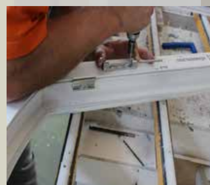
Colocación de Herrajes
